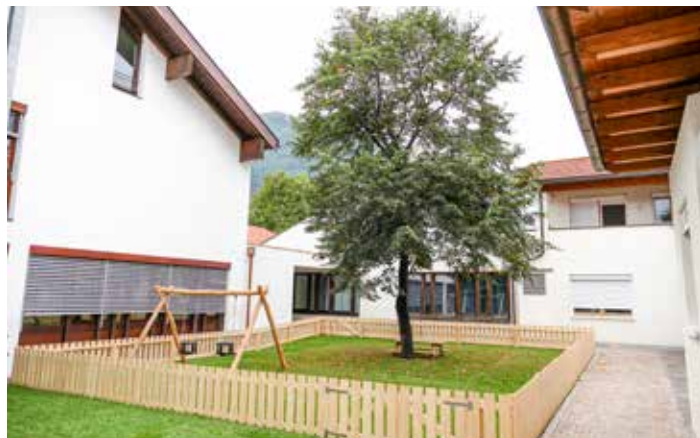
Die neugestaltete und umzäunte Grünfläche vor der neuen Kita.
